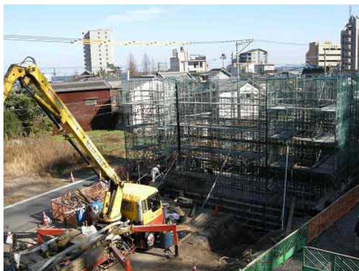
図 1-1 県道別府狭間線の橋脚工事
